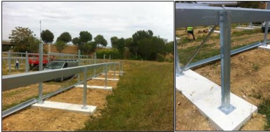
Figure 6 : Longrines en béton.
