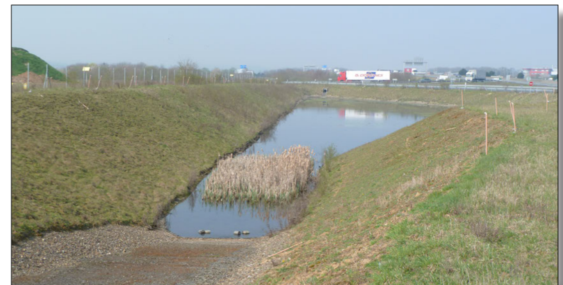
Photo 15 : Bassin de rétention situé en bordure du site de Jules Verne
