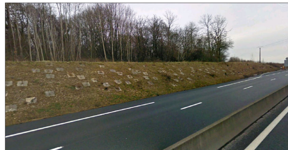
Photo 8 : Boisement bordant l'autoroute
