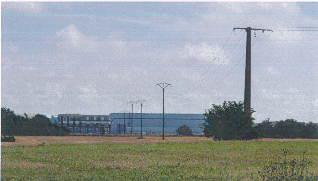
5 Vue Est vers Ouest du terrain
