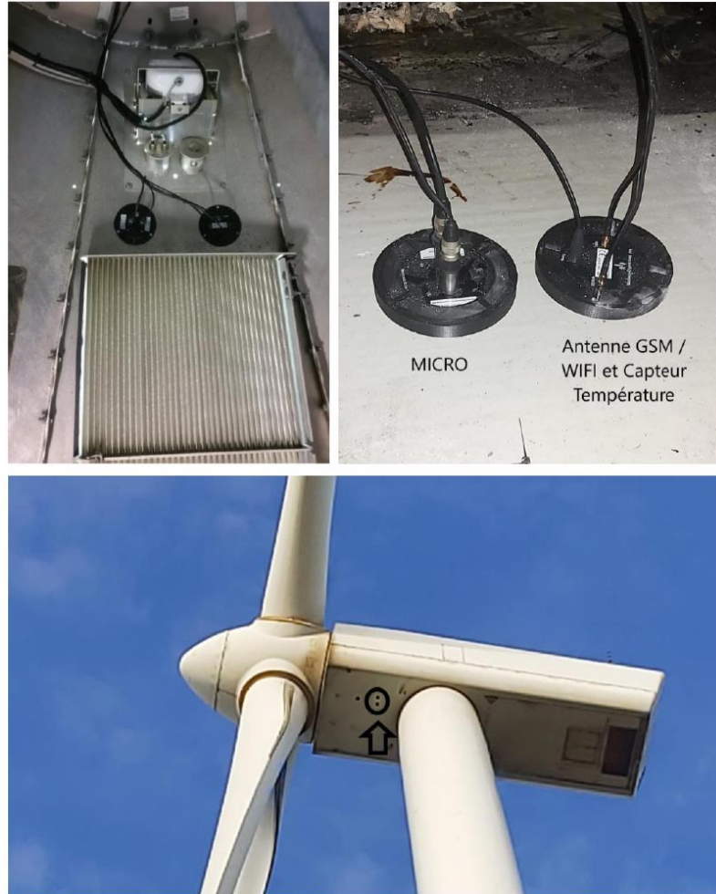
Figure 1 : Installation du BATmode en nacelle
