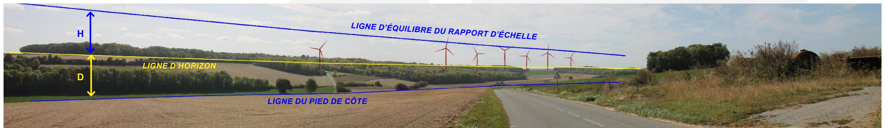
PM 24 - Templeux-la-Fosse - Départementale 181 : Ici le rapport est légèrement défavorable pour 3 éoliennes.
