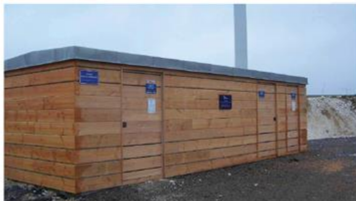
Figure 11 : Exemple de poste de livraison avec un bardage bois
