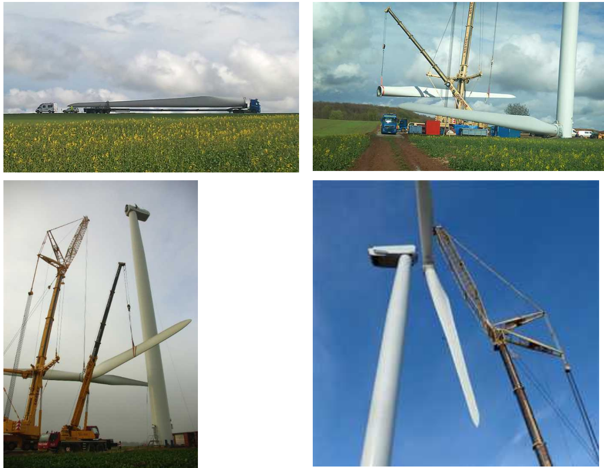
Figure 58 : Exemple de séquences d'assemblage d'une éolienne
