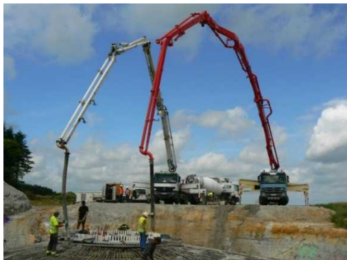
Figure 57 : Exemples de ferrailage et coulage des fondations
