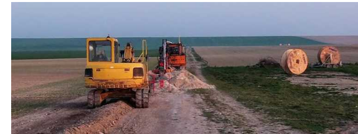
Figure 59 : Exemple de travaux pour l'installation du raccordement enterré
