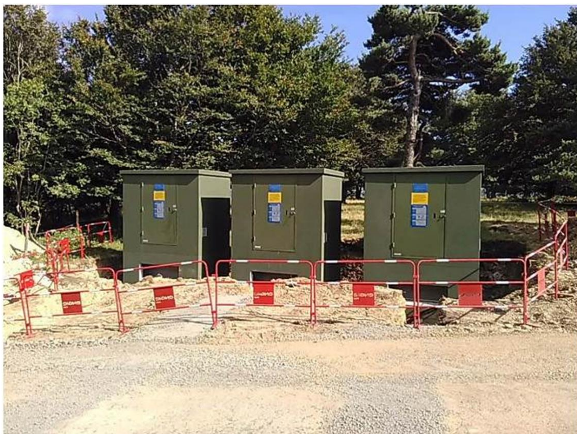
Figure 10 : Exemple d'armoires de coupure
