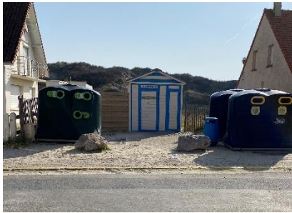
Sanitaires rue des vagues
