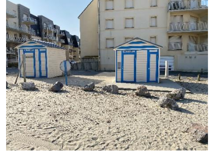
Sanitaires boulevard maritime nord
