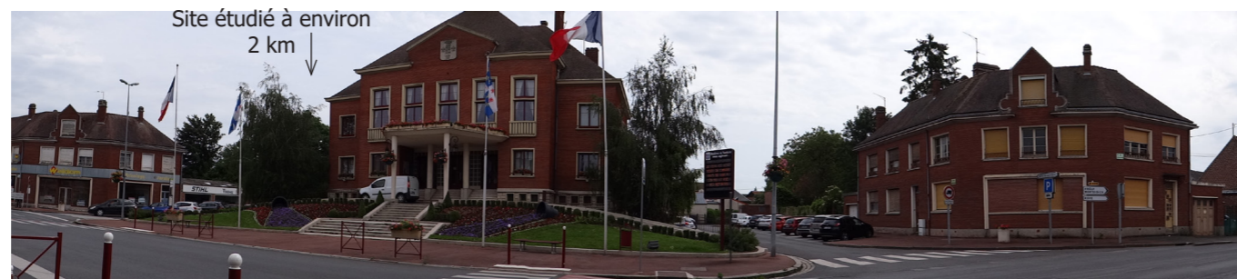
Photo49. Vue vers l'est depuis la mairie de Rosières-en-Santerre. Vue fermée par le bâti.
