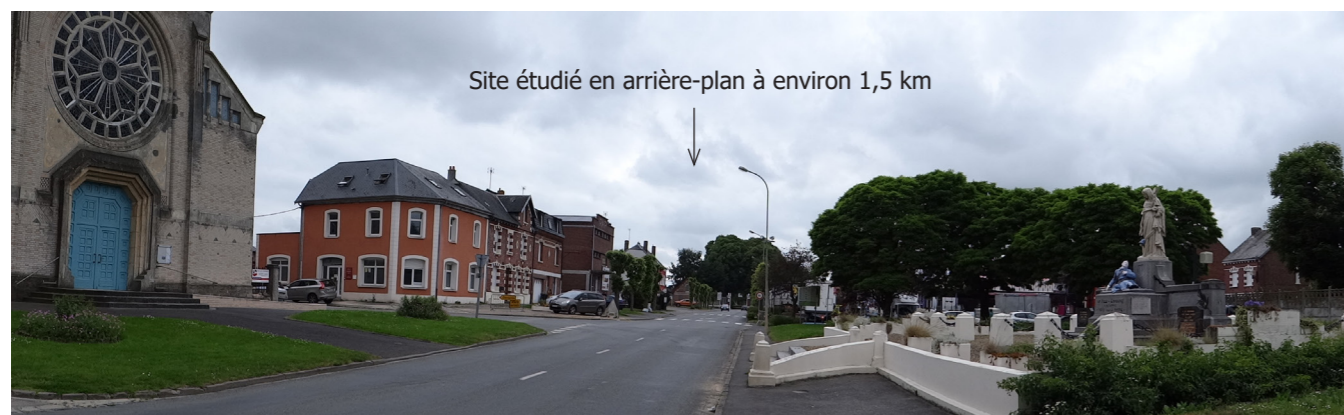
Photo56. Vue vers le sud-ouest en direction du site depuis la rue principale (église), vue fermée par le bâti.
