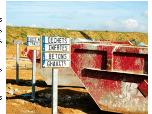
Exemple de benne pour un chantier
