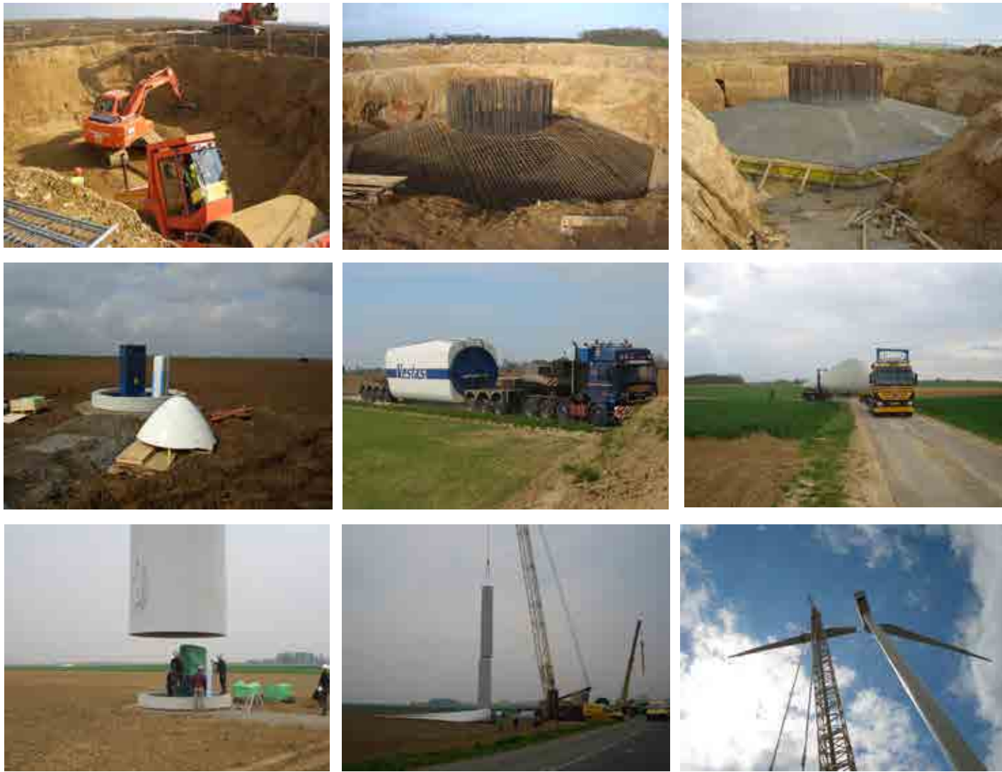
Photographie 2 : Aperçu des différentes phases de travaux
