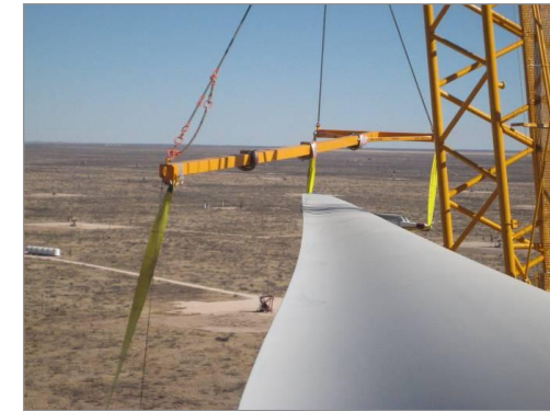
Figure 16 : photos du chantier - assemblage des pales
