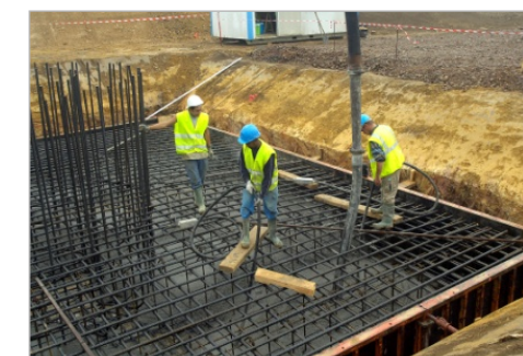
Coulage du béton
