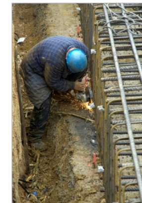
Préparation des fondations
