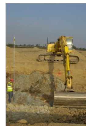
Fouille de la fondation
