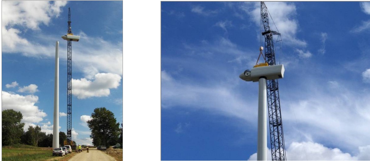
Figure 15 : photos du chantier - assemblage de la nacelle
