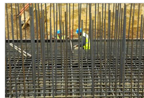
Ferrillage de la fondation
