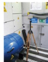
mesures n° 1 une mesure à l'arrêt une mesure en fonctionnement
