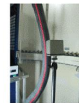
mesure n° 3 palier intermédiaire auprès du câble
